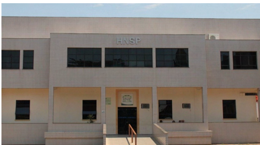
Figura 37. Hospital Nossa Senhora da Piedade, localizado em Paraíba do Sul (RJ).
